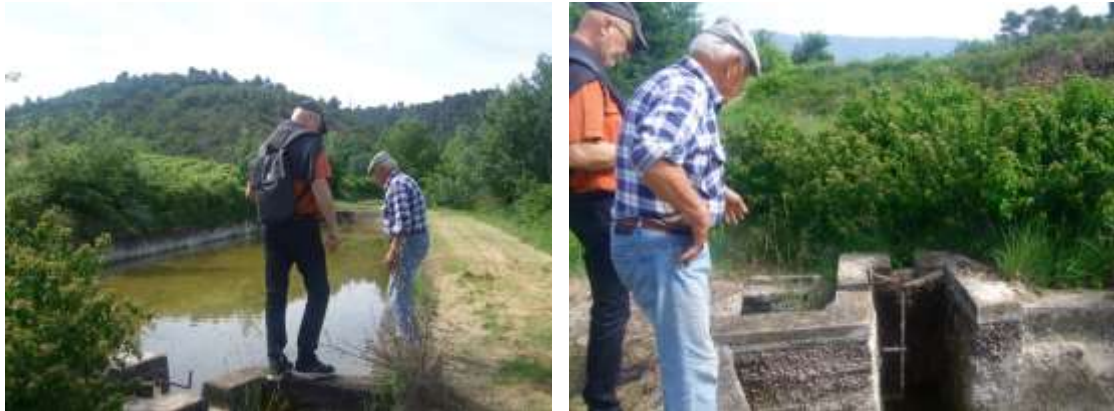
Le bassin et sa vanne à main
