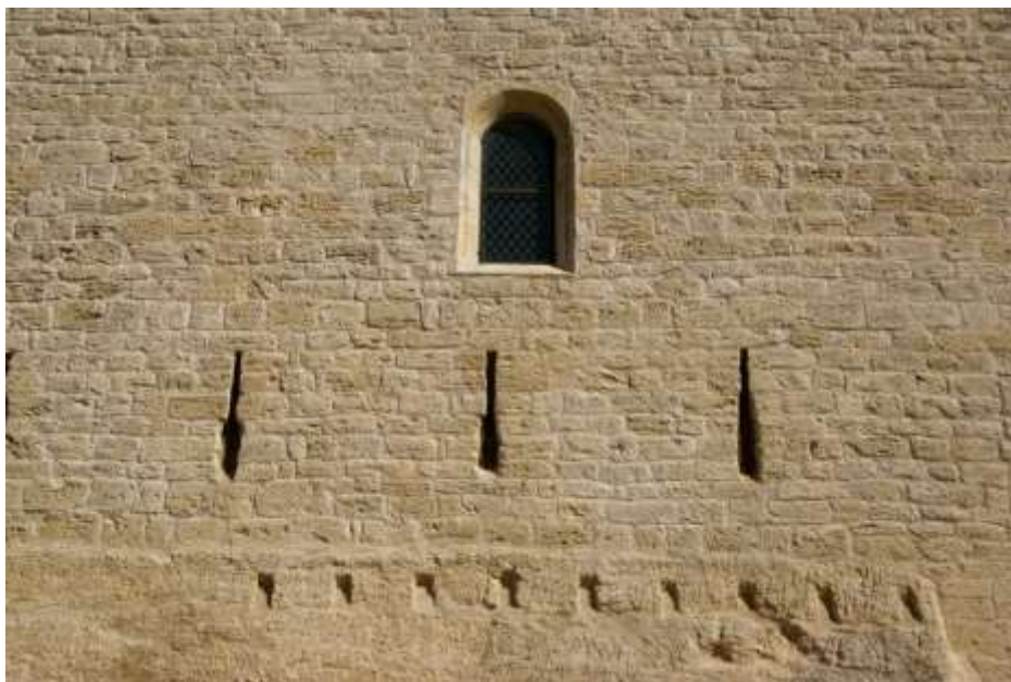
Les archères murées lors de la construction de l'église (photo Lionel GUIN)
